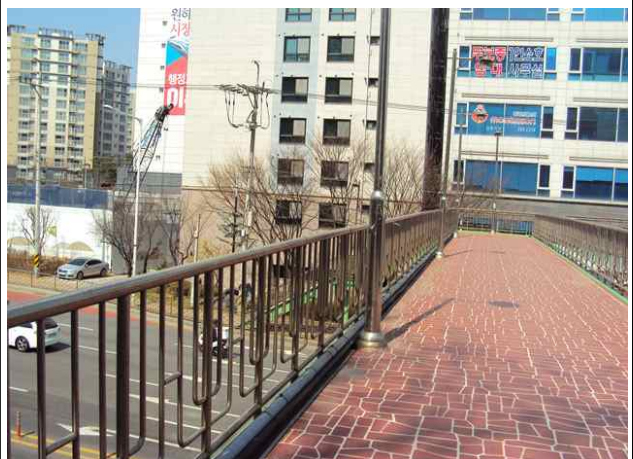
난간 및 연석 전경
