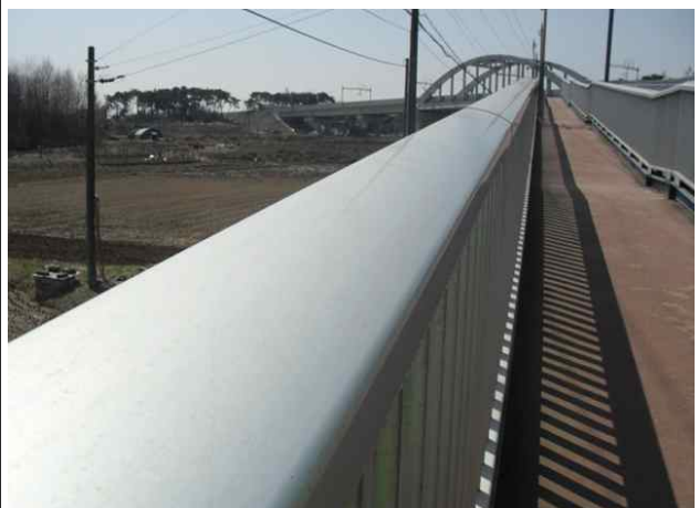
난간 및 연석 전경
