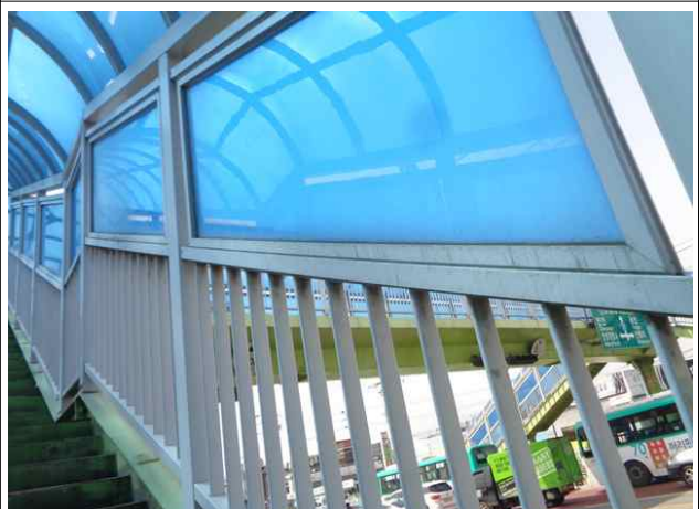
난간 및 연석 전경
