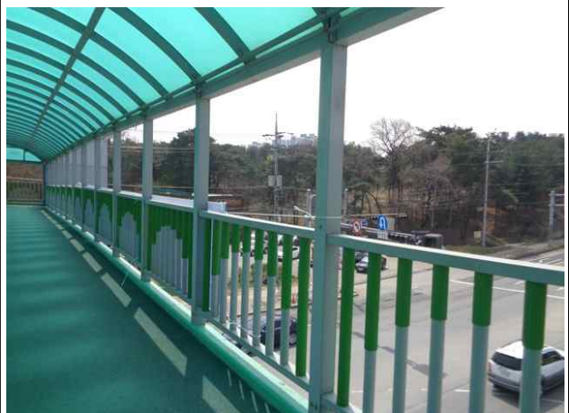
난간 및 연석 전경
