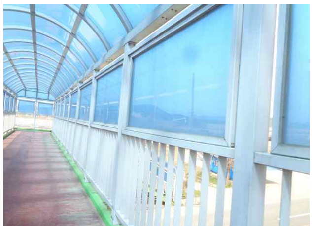
난간 및 연석 전경
